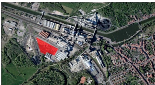
Zone projet de la chaufferie
