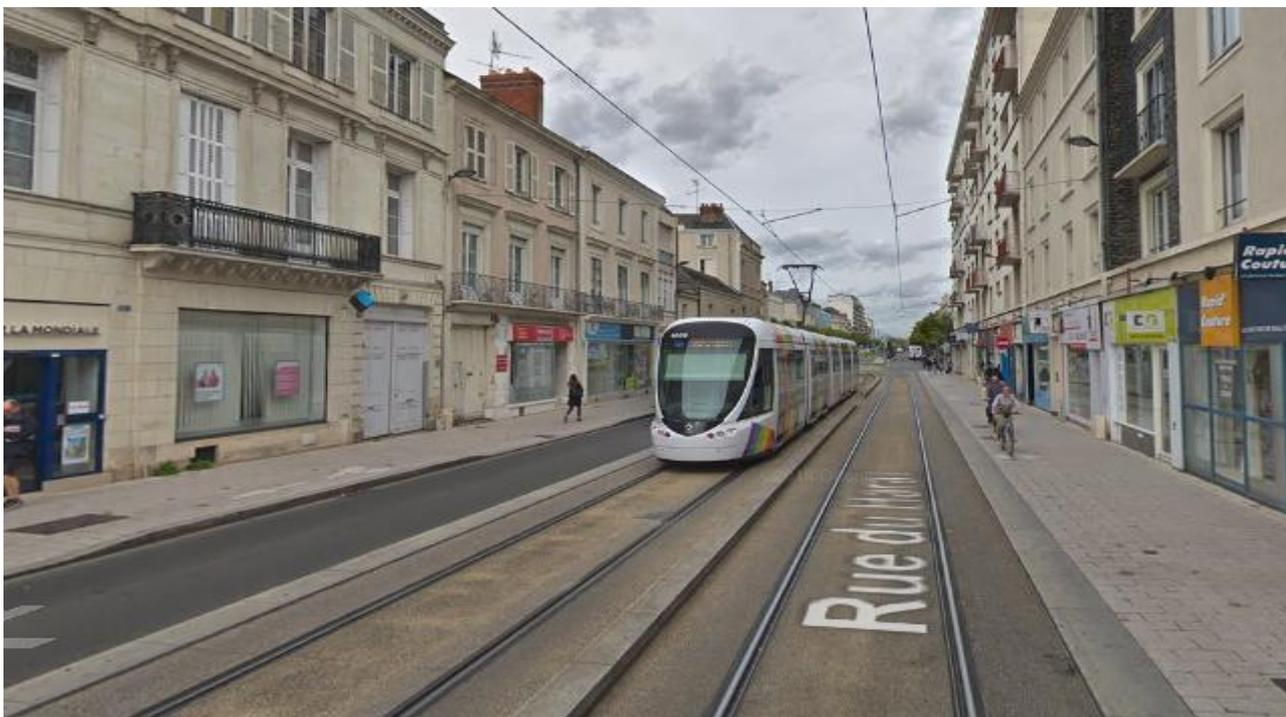
Exemple de bordure axiale entre les deux voies de tramway, tramway d'Angers
